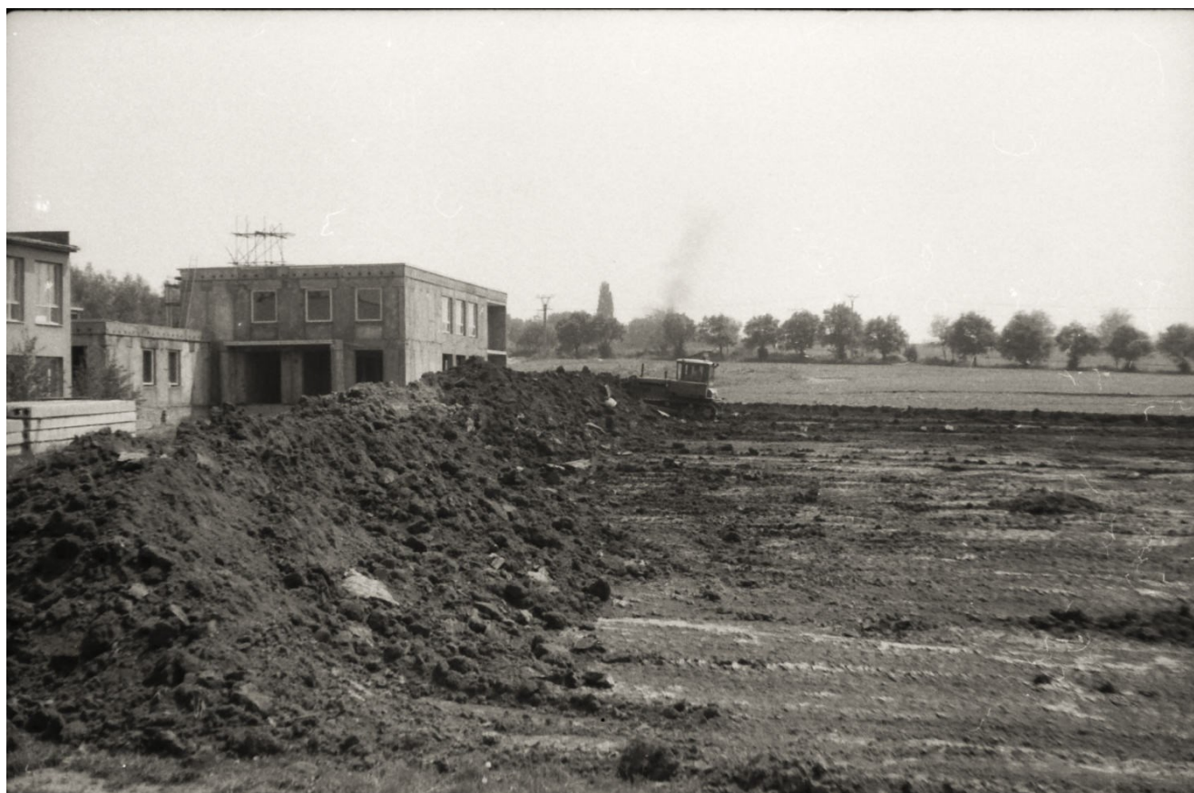
příprava stavby nové budovy základní školy
