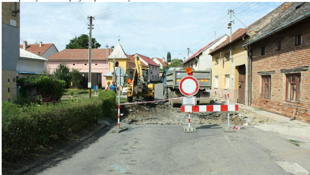
zahájení rekonstrukce komunikace a kanalizace ve Slížanech
