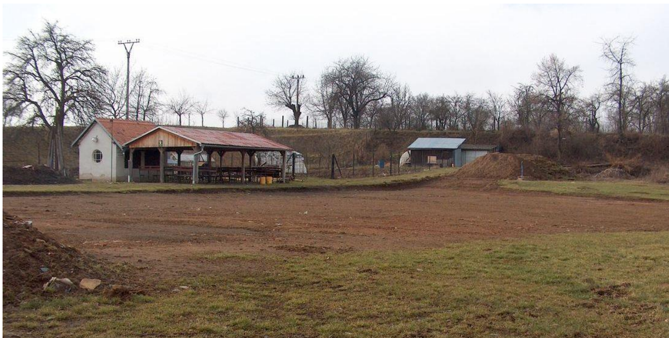
úprava plochy hřiště v Hliníku
