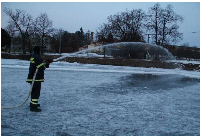
pokus o zlepšení kvality ledu nástřikem vody
