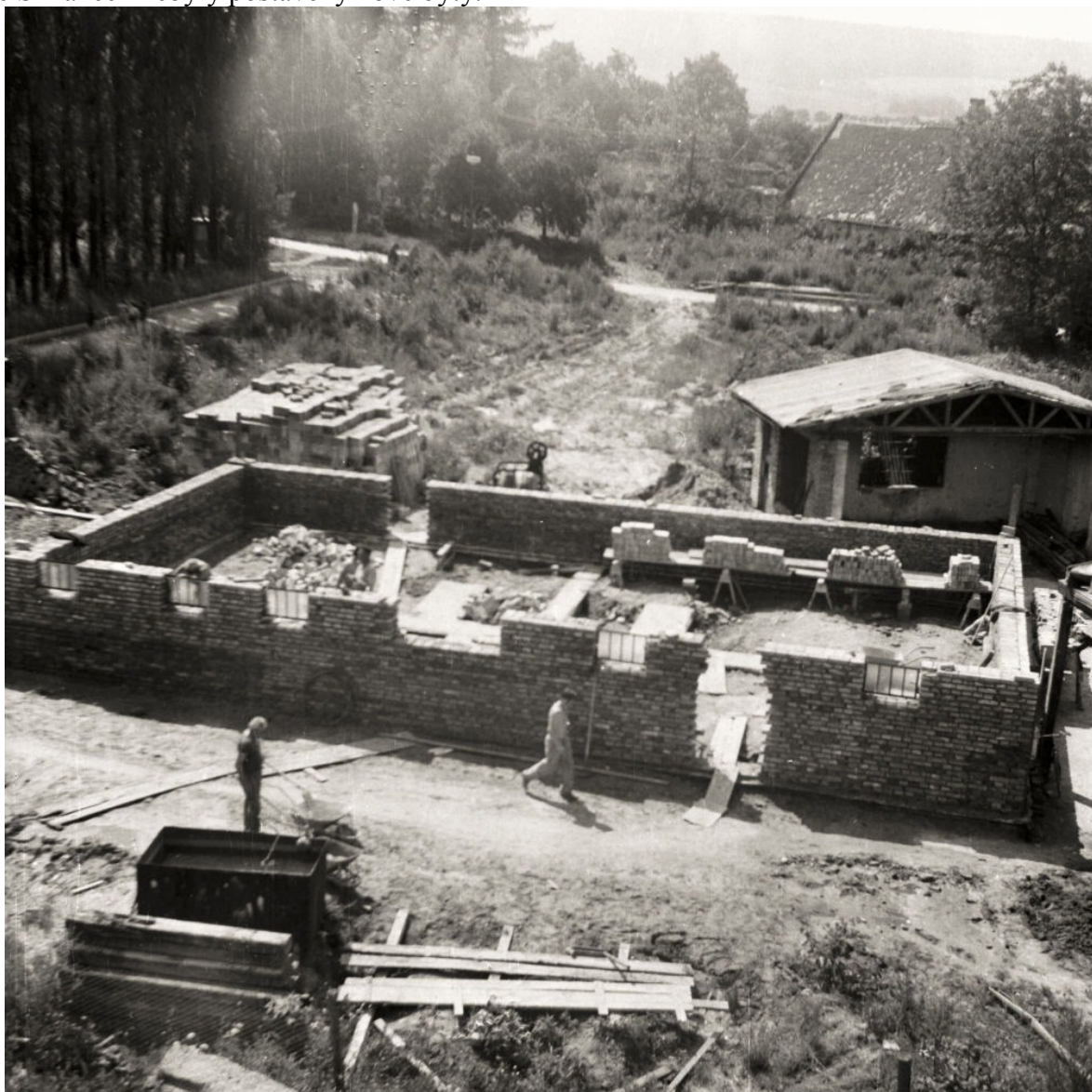
stavba bytového domu Školní 681
