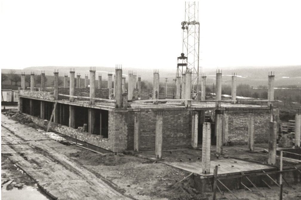
stavba nového pavilonu základní školy
