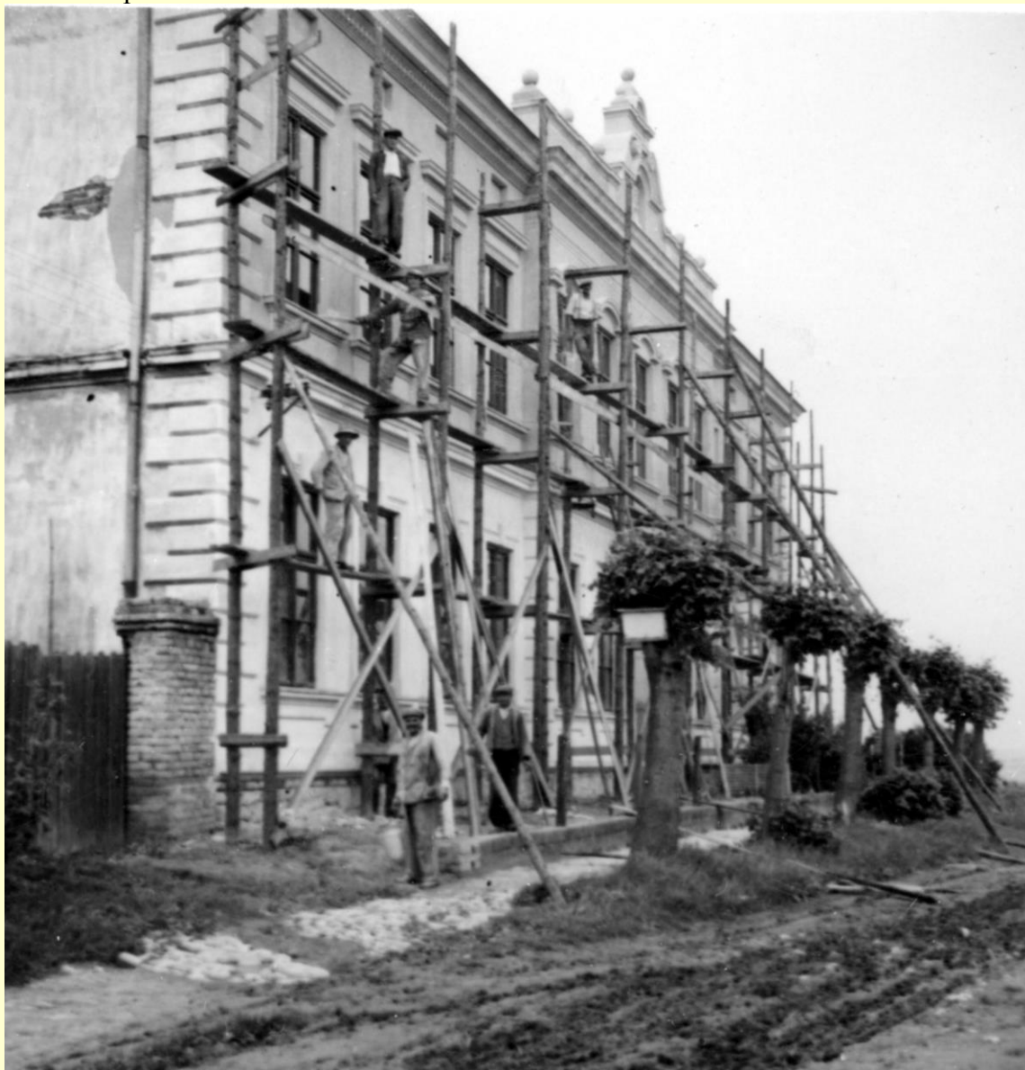
oprava školní budovy
