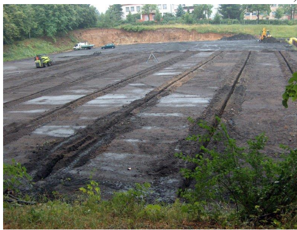
pokládání drenáže při stavbě hřiště
