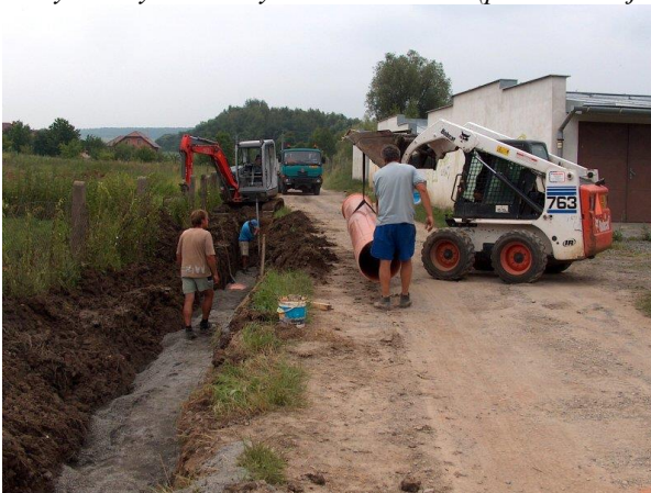
stavba kanalizace na ul. Jabloňová
