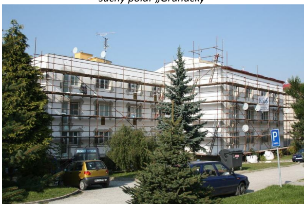
zateplení bytových domů č.p. 703, 706 a 708
