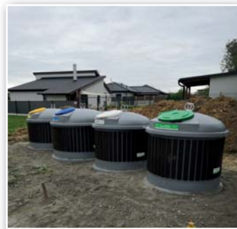
Polopodzemní kontejnery – rozestavěno ul. Trávníky (jedno stanoviště)
