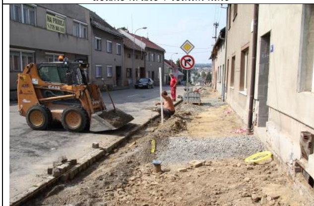
rekonstrukce chodníku na ul. Nádražní
