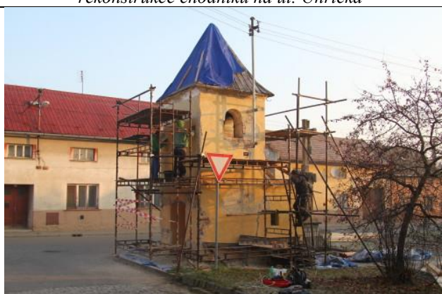
oprava zvonice ve Slížanech
