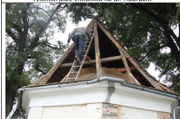
oprava kaple sv. Anny
