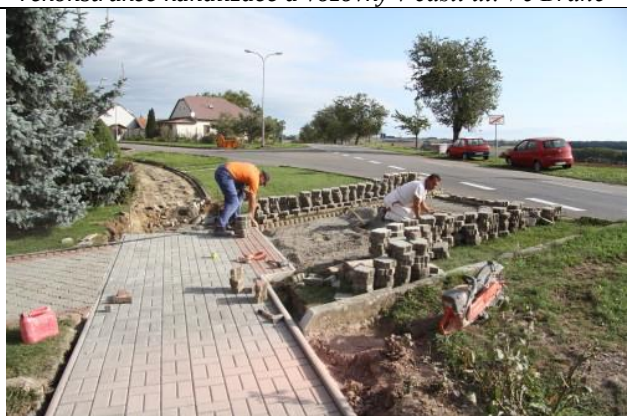
rekonstrukce chodníku na ul. Uhřická
