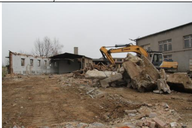
bourání části bývalého „Komunálu“
