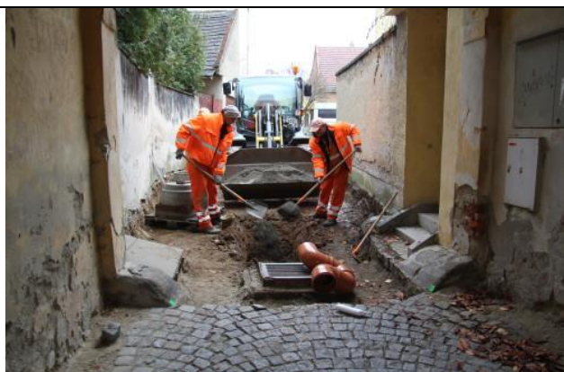
rekonstrukce kanalizace a vozovky v části ul. Ve Bráně
